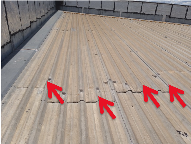
Figura 07 – Pontos a inserir parafusos.
