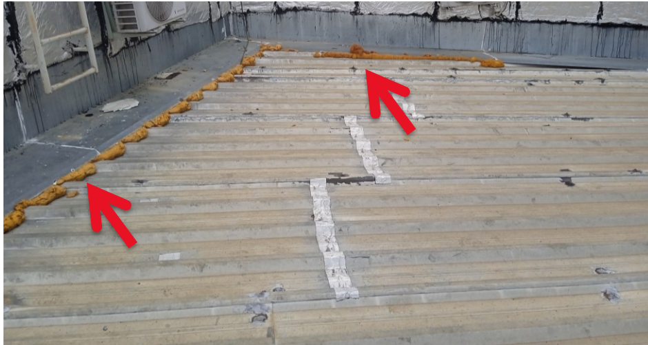
Figura 02 – Indicação dos locais com espuma a remover
