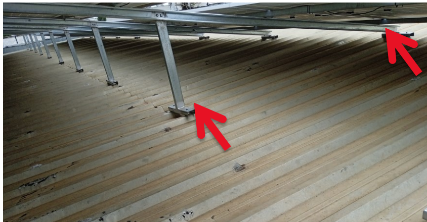
Figura 11 – Indicação de parafusos a vedar com PU.
