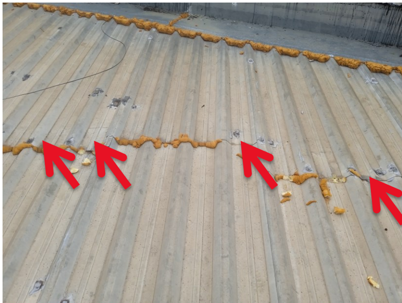
Figura 06 – Pontos a inserir parafusos.
