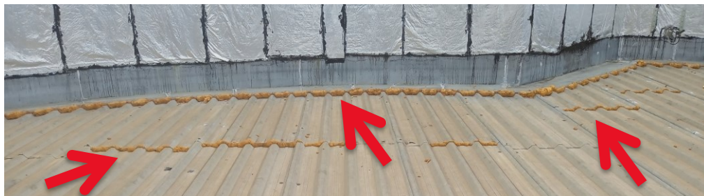
Figura 04 – Indicação dos locais com espuma a remover
